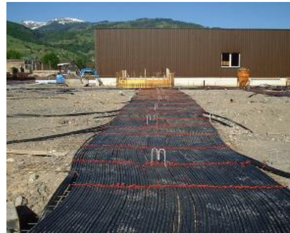
Horizontale Leitungsführung
